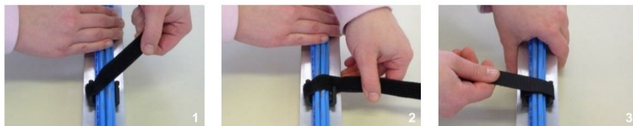
Bündelung: Bündel einlegen (1) – Spannen & Rückführen (2) – Fixieren (3)
